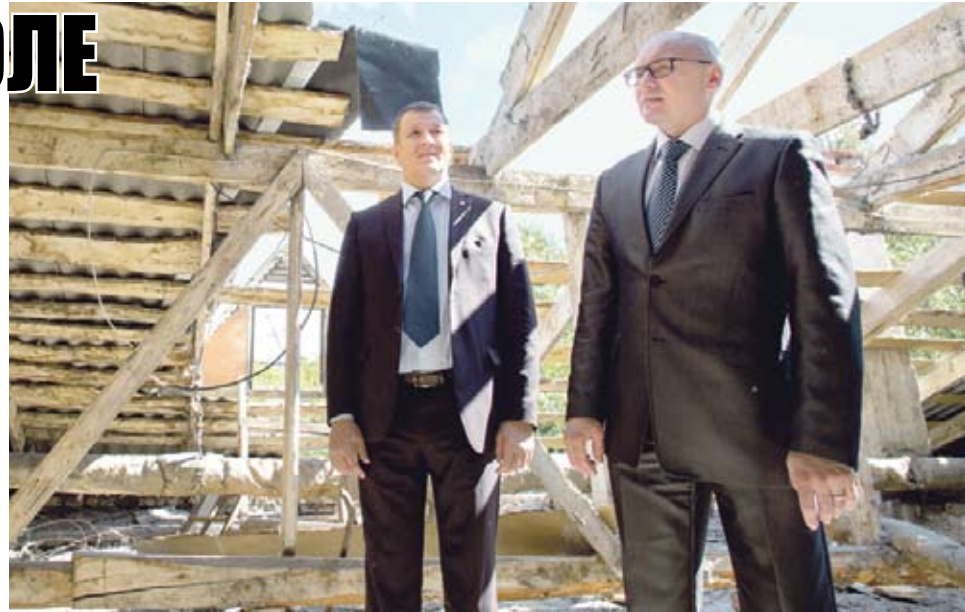
Ради проверки хода капитального ремонта представителям «Народного контроля» порой приходится спускаться в подвал и подниматься на чердак.
