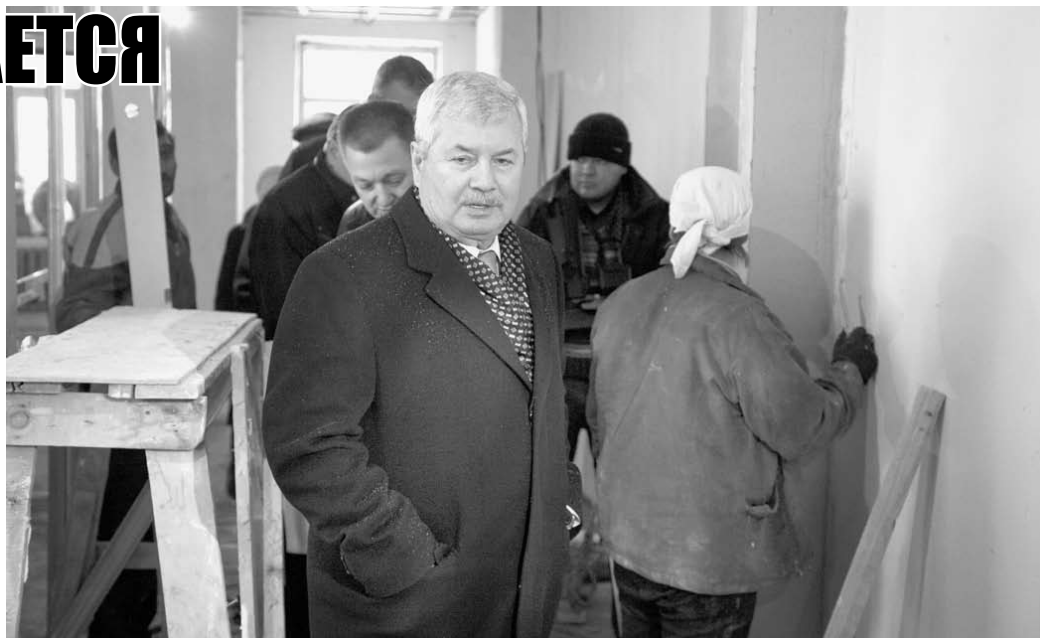
Владимир Мякуш проверил, как идет капитальный ремонт детской поликлиники
